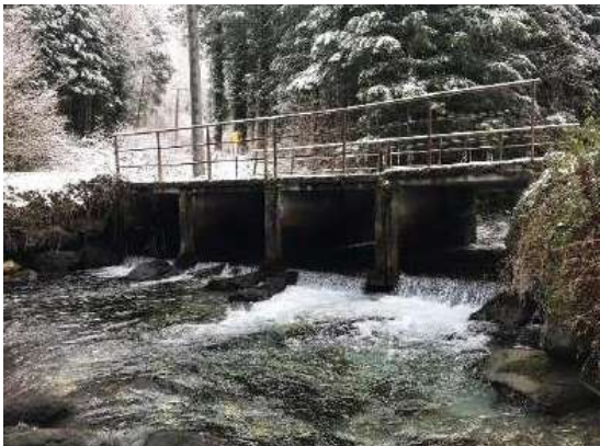
Pont de Ramière
