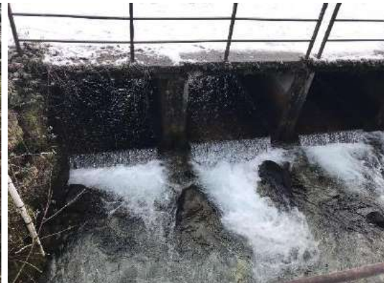
Pont de Salfaji
