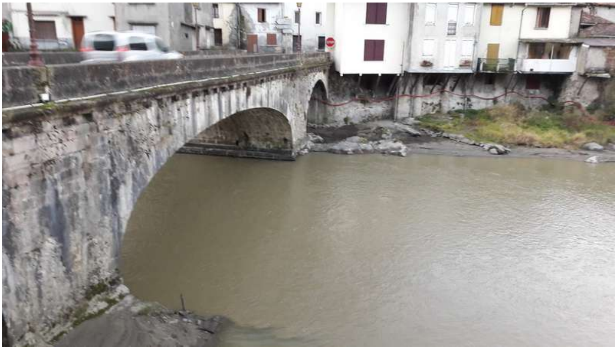
Figure 2 pont de Lacourt 21-12-2016
