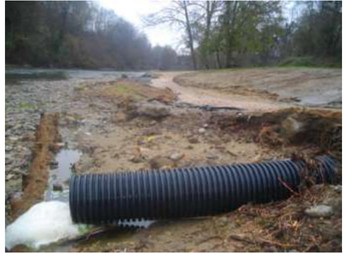
Exutoire de la station d'épuration
