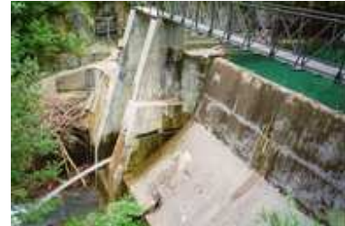
Un débit réservé sur le Vicdessos
